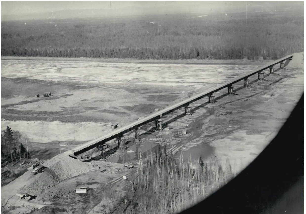
Временный мост через реку Витим.
