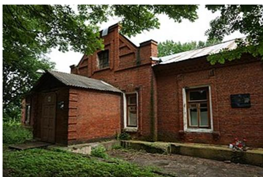
здание бывшей Уездной больницы в Переславле-Залесском, в котором с 1910 по 1916 гг. работал главным врачом и хирургом В. Ф. Войно-Ясенецкий
